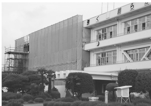
耐震化・大規模改修が進められている双葉北小学校 (福島県双葉町)
